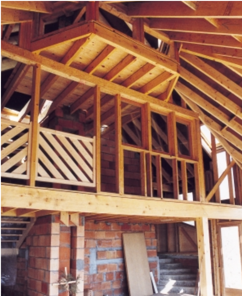
Le volume du séjour et de la mezzanine en construction.
